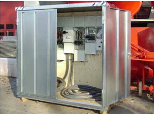
SC3000 als Einhausung für einen Stromverteilerkasten
