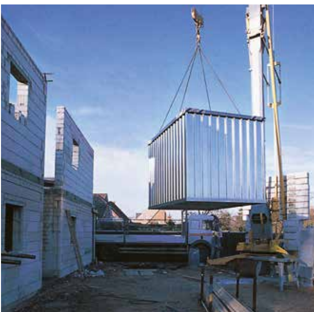
Mit 4 serienmäßigen Kranösen bis 3 Tonnen kranbar
